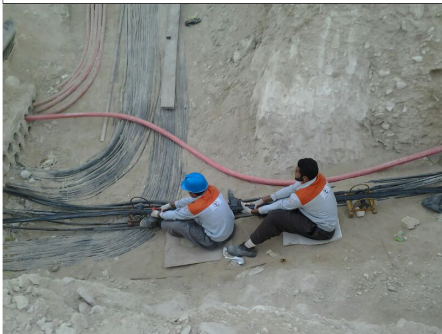
عکس شماره ۴: کارگران در حال کابل کشی با حداقلی‌ترین ابزارهای موجود
