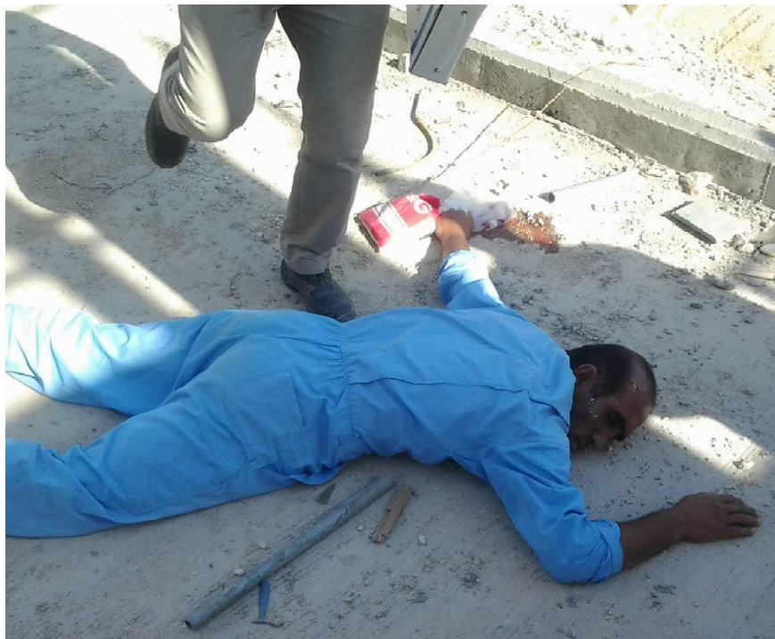
عکس شماره ۲: سقوط و مرگ یک کارگر؛
