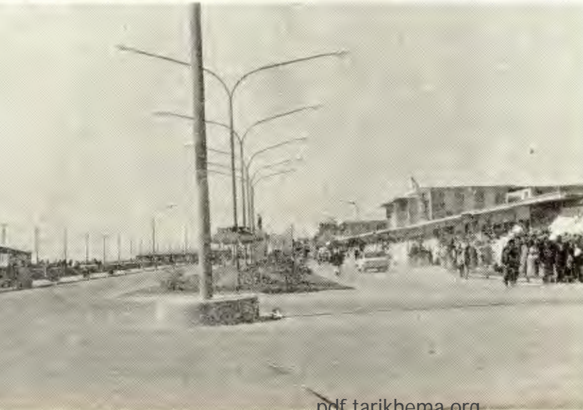
بلوار وساحل خلیج بحرمان که بوسیله یکی از شهرداریهای بحرمان ساخته شده است
