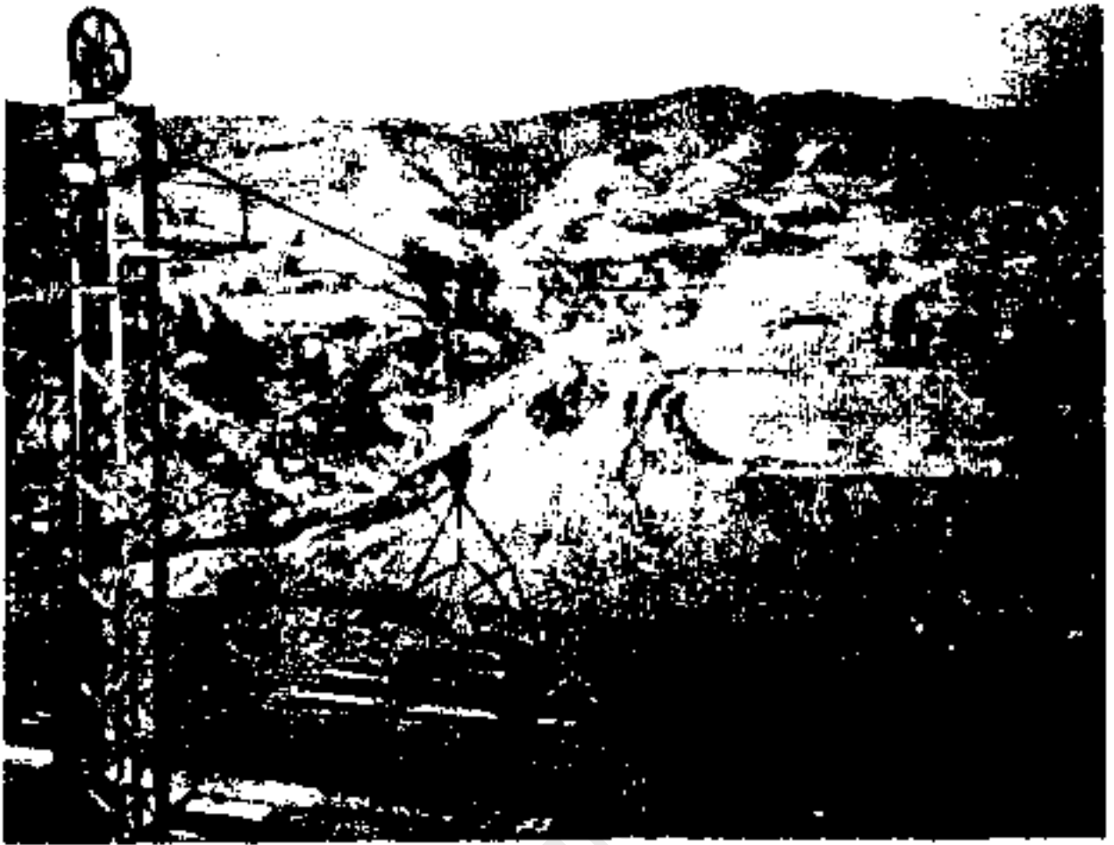
دستگاه (فی لی) یا جرثقیل مخصوص حمل وسایل سنگین از روی رودخانه کارون در مطفه بنتی لالی
