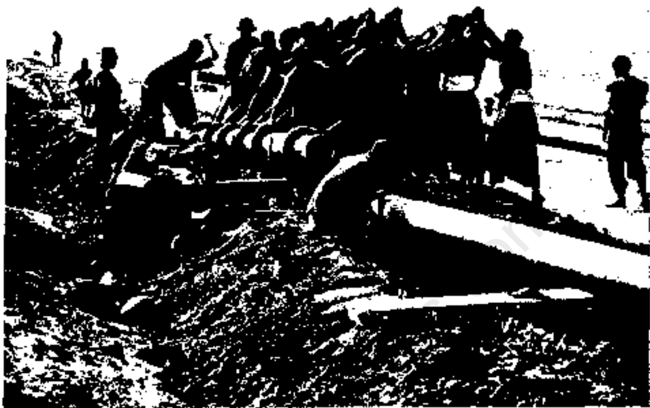
پیچ دادن و وصل کردن توله‌های نفت در سال ۱۹۰۹ توسط پختیار پها
