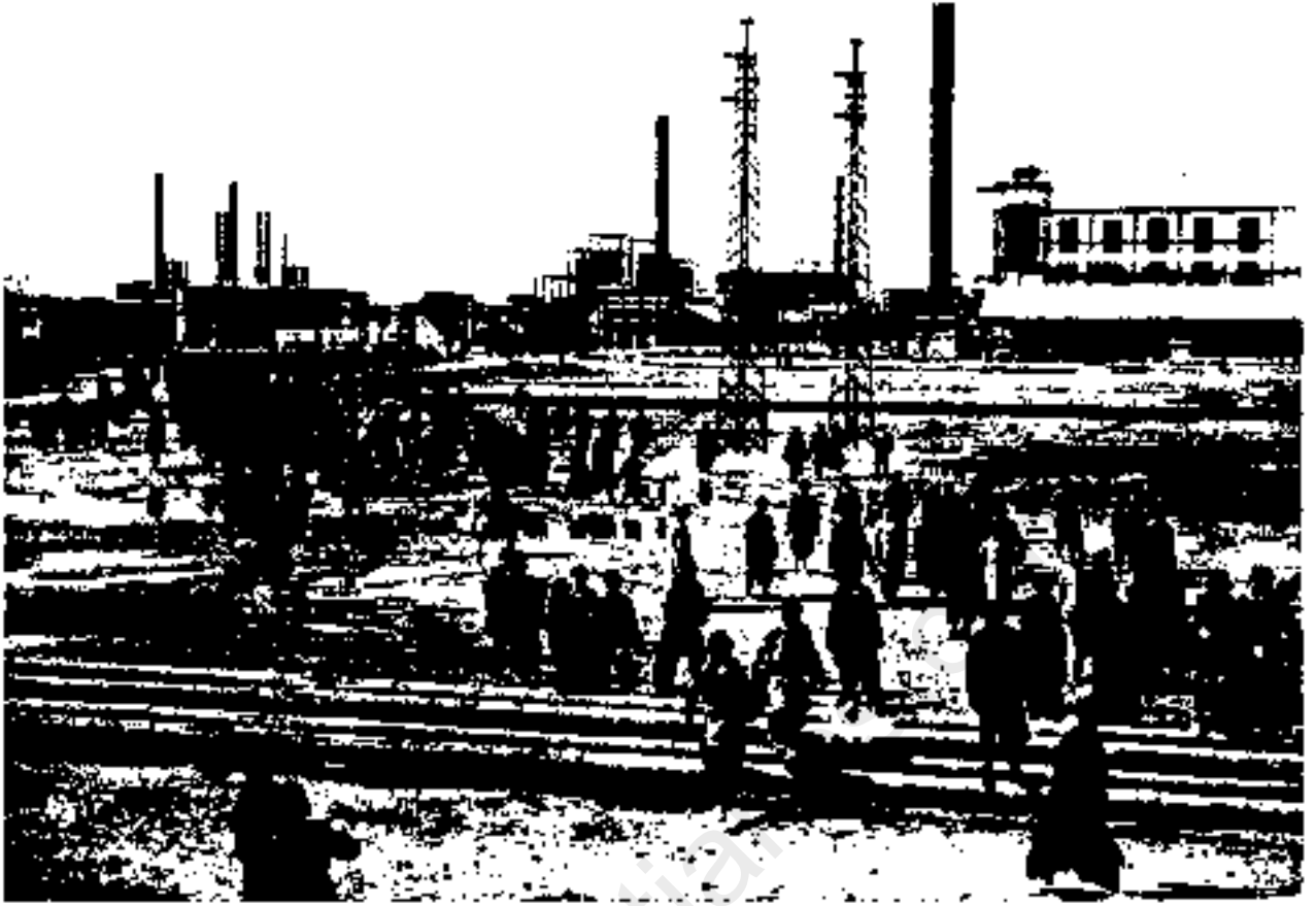
موقع ختم کار در تصفیه خانه آبادان
